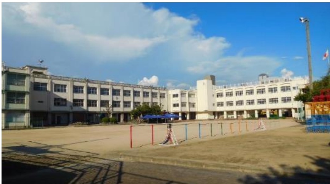
写真：生野南小学校
